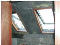
Schon eine Fuge von 1 mm in der Dampfbremse führt zu einem Feuchteintrag von 800 g Wasser/m<sup>2</sup> in die Dämmung pro Tag. (Quelle: Velux Broschüre - Luftdichtheit - Luftdichtes Bauen). Es ist also besonders wichtig mit dem entsprechenden Know-how an einen Innenausbau heran zu gehen.
