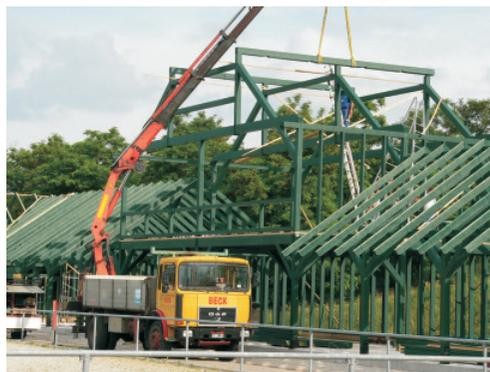
Der Gebäudekomplex mit insgesamt 60 m Länge wurde abgebunden und dann vor Ort montiert. Durch die trockene Bauweise entstanden keine Wartezeiten für die Entfeuchtung des Bauwerkes. Die Dacheindeckung mit schwarz glasierten Dachziegeln verleiht dem imposanten Bauwerk noch zusätzlich einen eleganten Touch. Die "Feuerprobe" wurde bei einem 7 Tage andauernden Turnier bereits mit Bravour bestanden.
